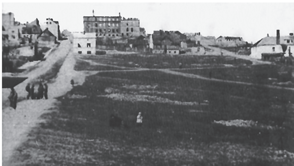
Budowa ulicy Zjazd, którą pokonywali od 1934 r. łomżyńscy kibice na mecze piłkarskie. U góry po prawej wznoszony budynek Gimnazjum Żeńskiego, potem m.in. „Budowlanki”, u dołu budynek piekarni. Zbiory Archiwum w Łomży
