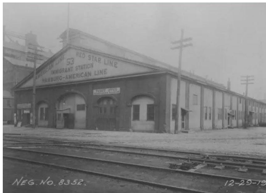
Fot. 3. Budynek odprawy granicznej w Philadelphii
