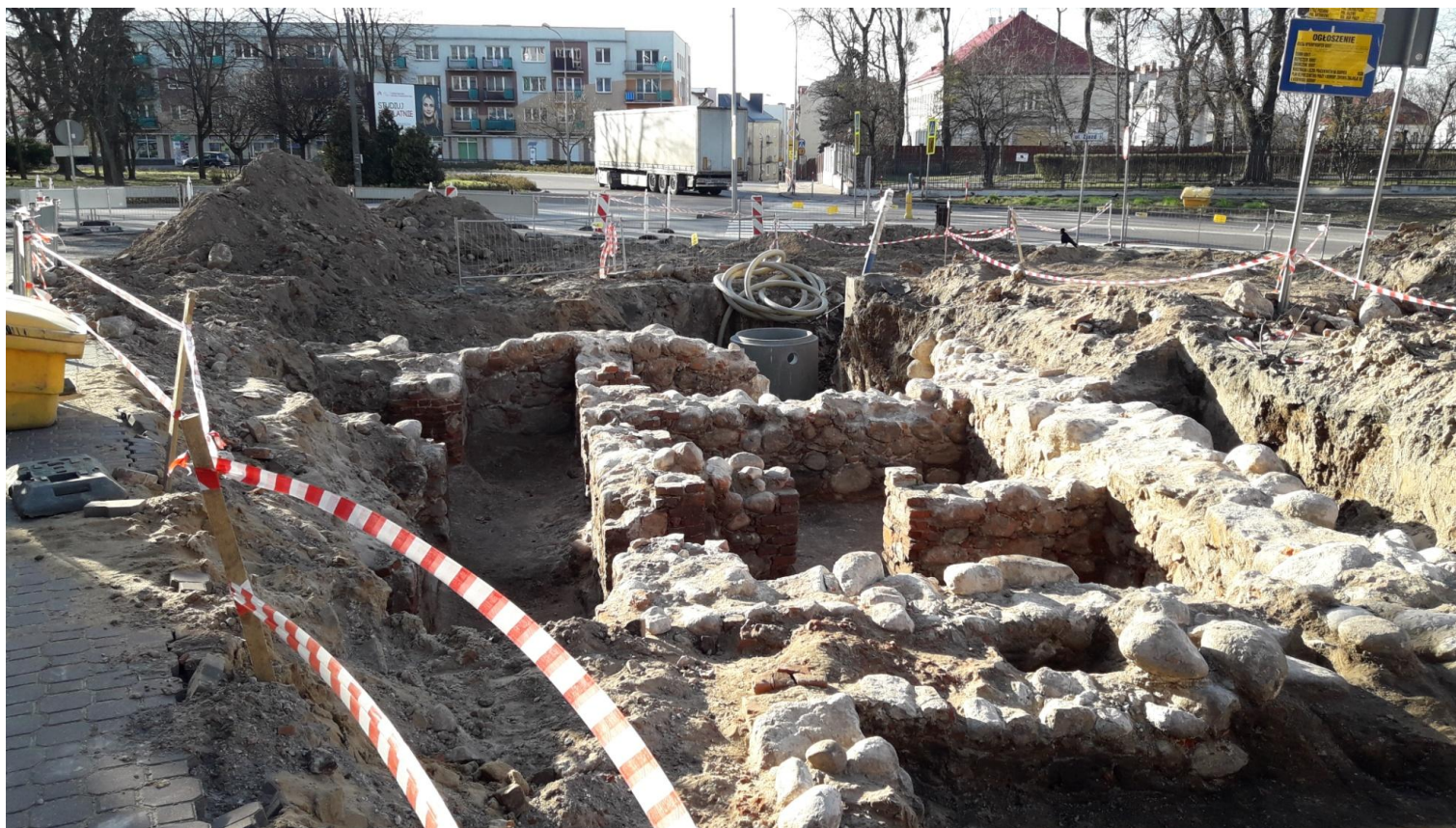
Odślonięte fragmenty fundamentów Hotelu Polskiego. Fot. Mirosław R. Derewońko
